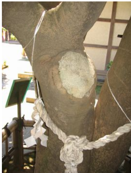
・大枝切除跡にモルタルが充填されている(北側)
